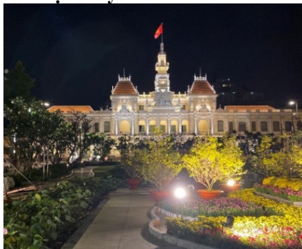
Hình 2. Trụ sở UBND TPHCM, phường Sài Gòn, TPHCM
